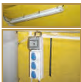
Impianto elettrico e di illuminazione.
