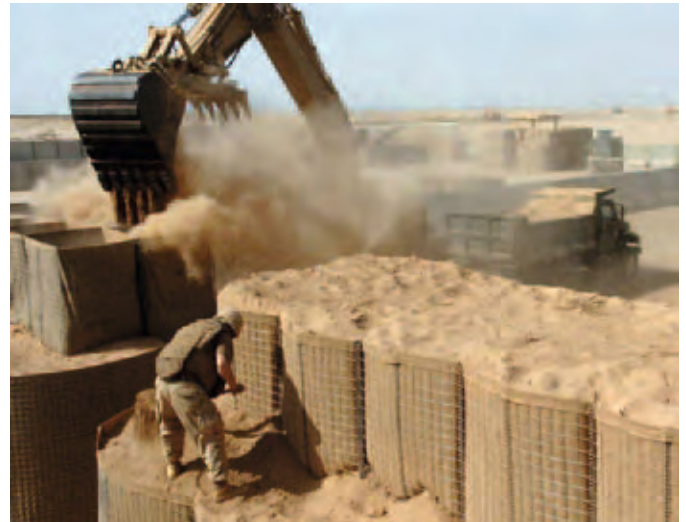
Per erigere le barriere vengono utilizzati i materiali locali con conseguente risparmio di tempo e risorse
