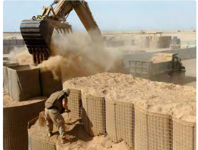
Per erigere le barriere vengono utilizzati i materiali locali con conseguente risparmio di tempo e risorse
